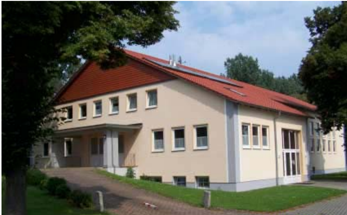
Mehrzweckhalle in Lindau Erneuert im Rahmen der Stadtsanierung
